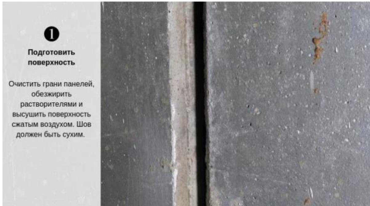
С помощью шпателя и щетки очистить грани панелей от грунтовки и пропитывающих составов.
